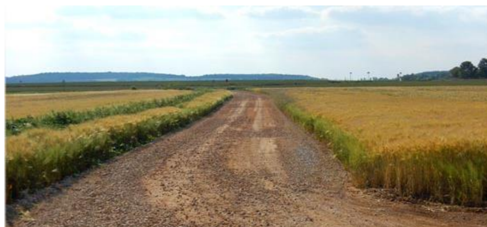
Photo 2 : Exemple de voie d'accès à un parc éolien
