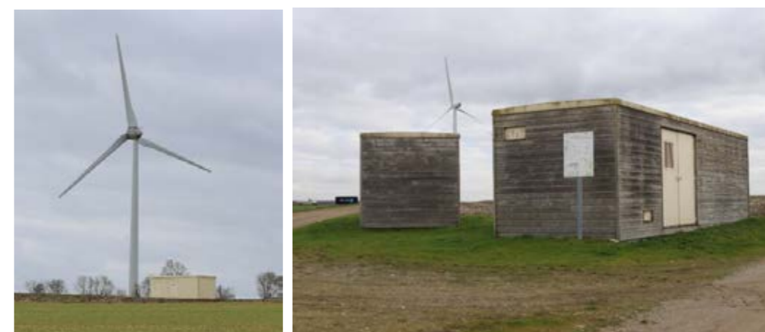
Photo 3 : Exemples de poste de livraison électrique
